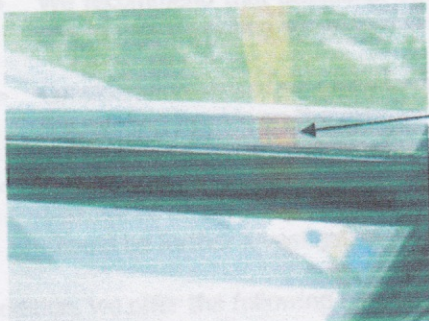
Fig. 11 - spacer bar degradation
